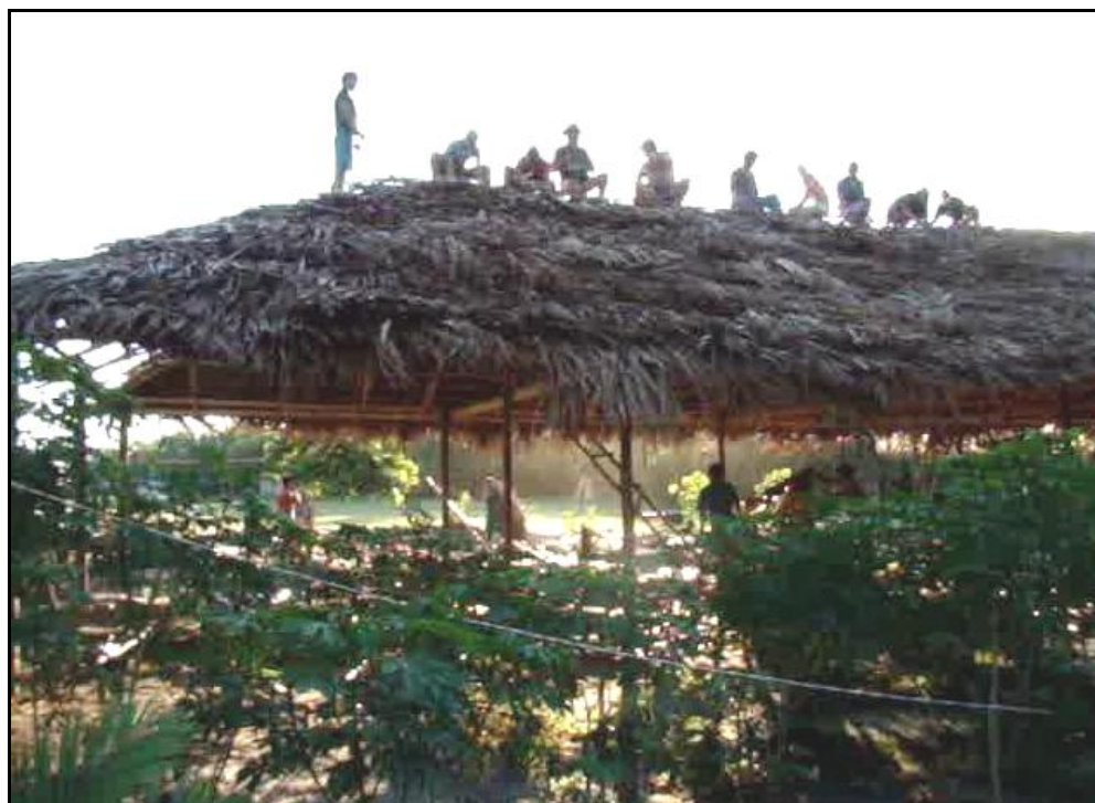
Figura 18 – Construção do Barracão para sediar o evento. Foto: Aquiles Pinheiro, 2010.
