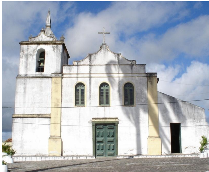
Fig. V - MECENAS, Ane L. S. Fachada da Igreja de Nossa Senhora do Socorro, 2009
