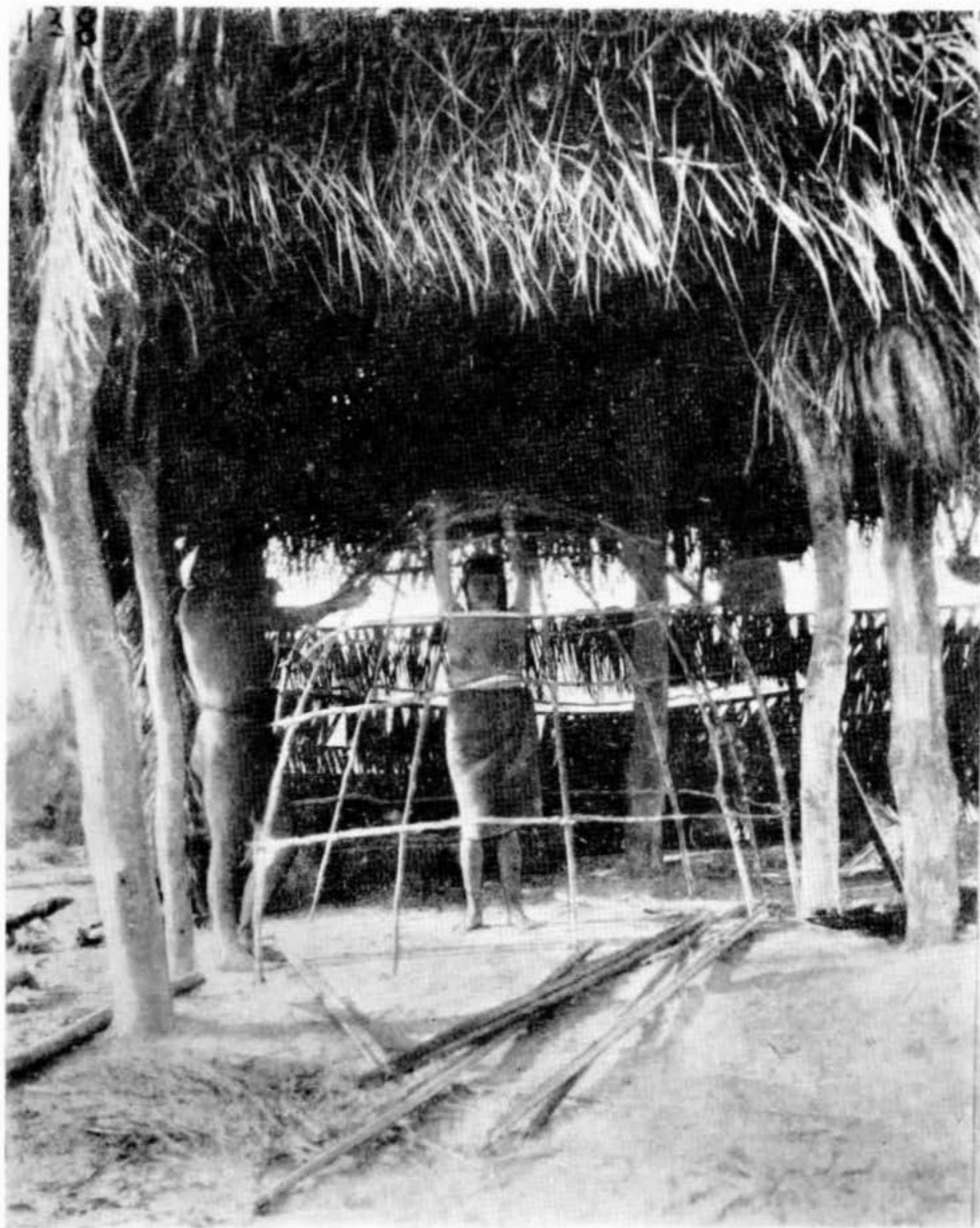
Construção do quarto de reclusão
